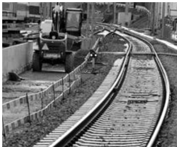
Die Arbeitgeber im Gleisbau taten es dem Baumeisterverband nach und sagten aufgrund der «Fachstelle Risikoanalyse» die Lohnverhandlungen ab. Bild: Colette Kalt
