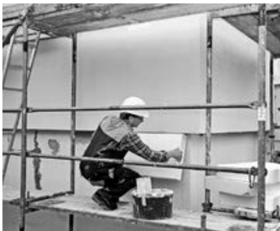
Die Arbeitnehmenden in der Gebäudehüllenbranche erhalten während der Dauer des GAV eine generelle Lohnerhöhung. Bild: Fotolia
