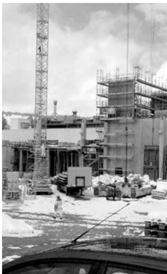
Die Bauarbeiter mussten Temperaturen von -15^{\circ}\text{C} bis +36^{\circ}\text{C} aushalten, das war nicht immer einfach.
