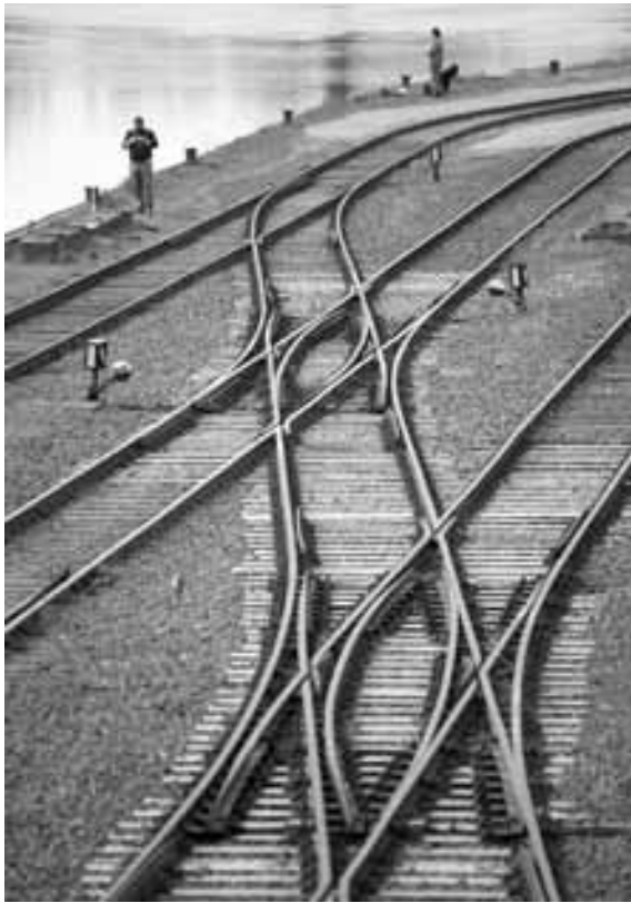
Le vide conventionnel dans la construction de voies ferrées a pu être évité.
