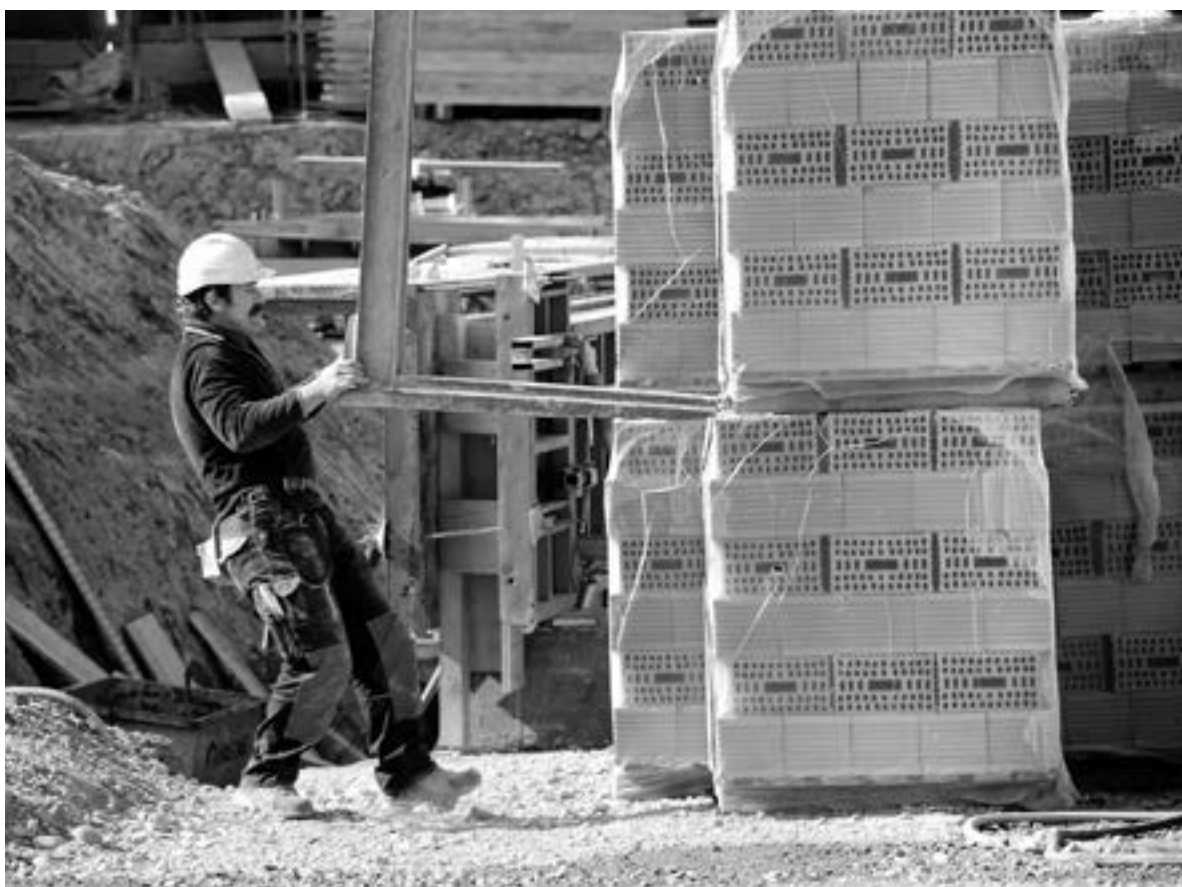
2014 fut une année difficile pour le partenariat social dans le secteur principal de la construction. Photo: Ernst Zülle
